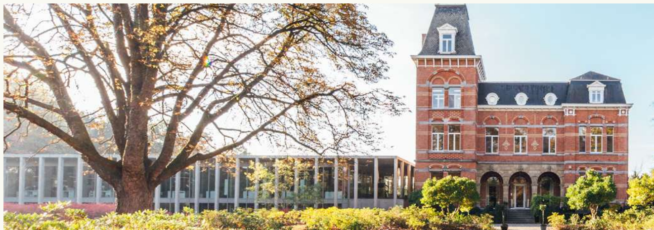
Uitbreiding kantoor: kasteel Ter Poorten Hasselt
