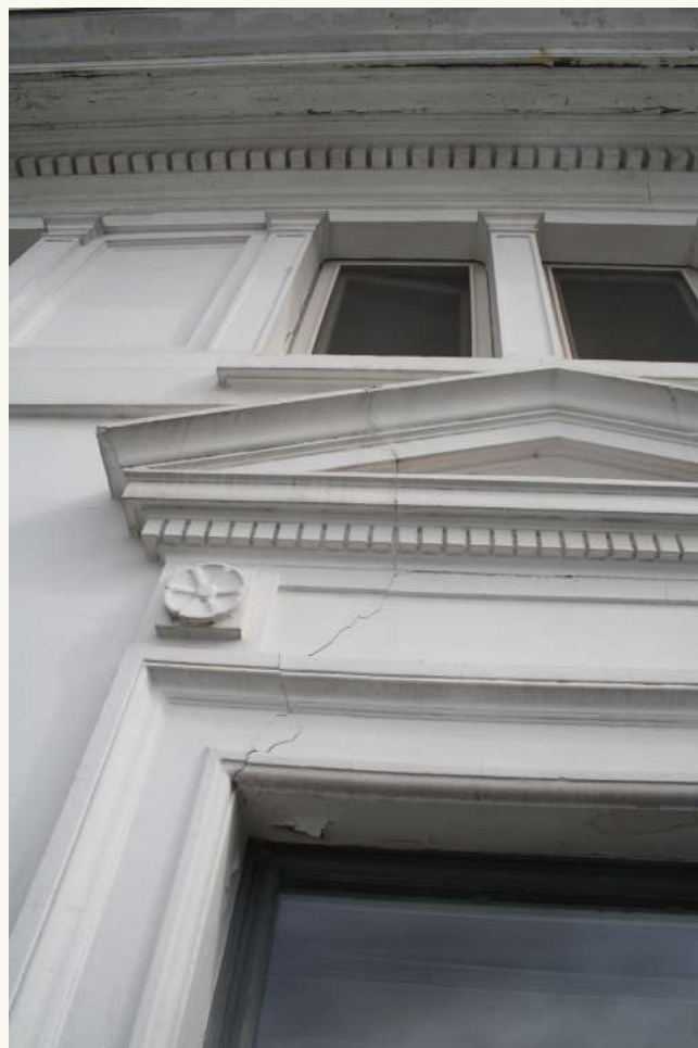
scheur vraagt extra onderzoek
