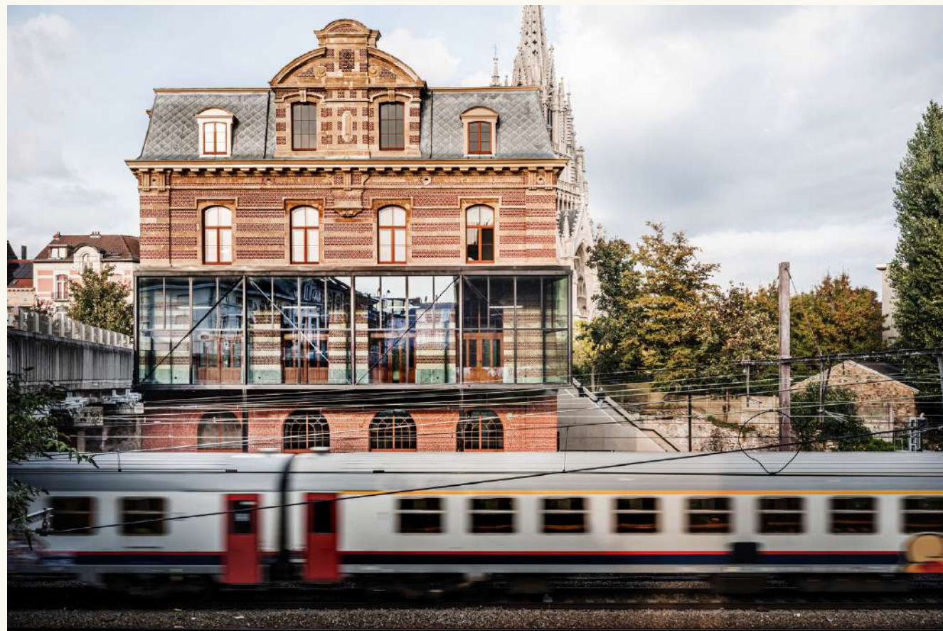
station Laken (B-architecten)
