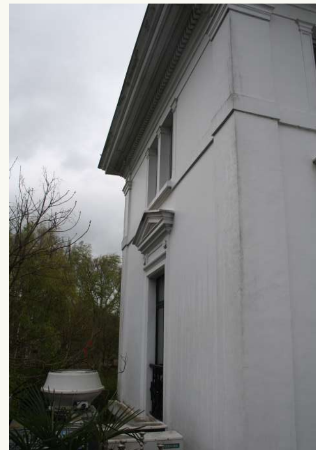
westgevel vanaf plat dak +1
