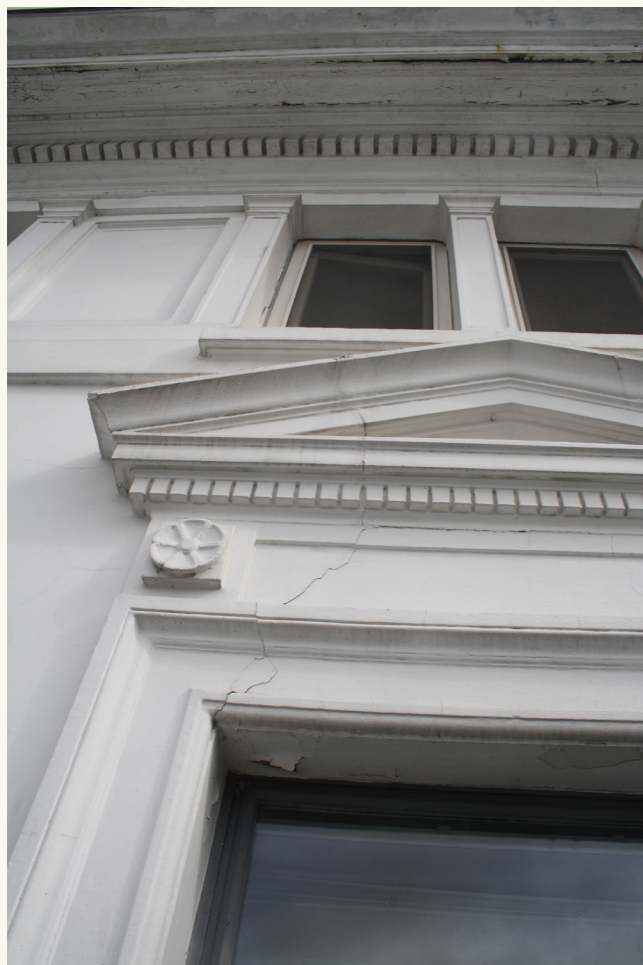
scheur vraagt extra onderzoek
