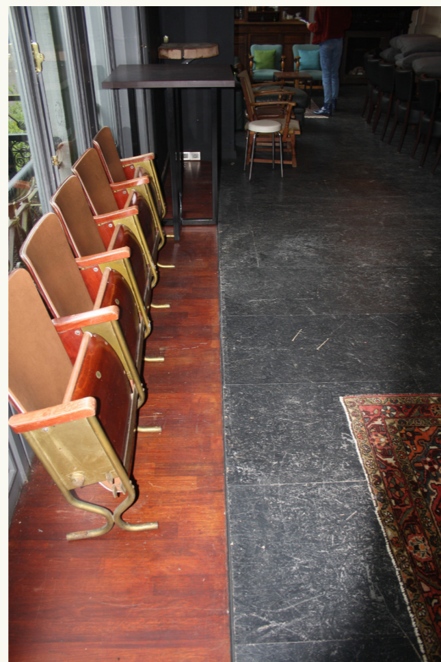
recente vloerafwerkingen, mogelijk bovenop originele
