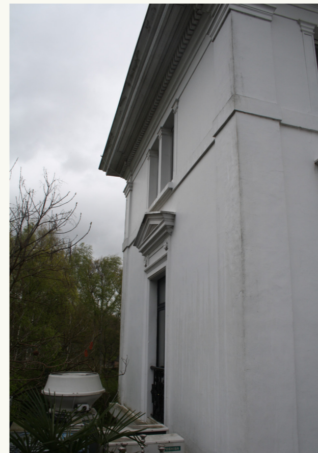
westgevel vanaf plat dak +1
