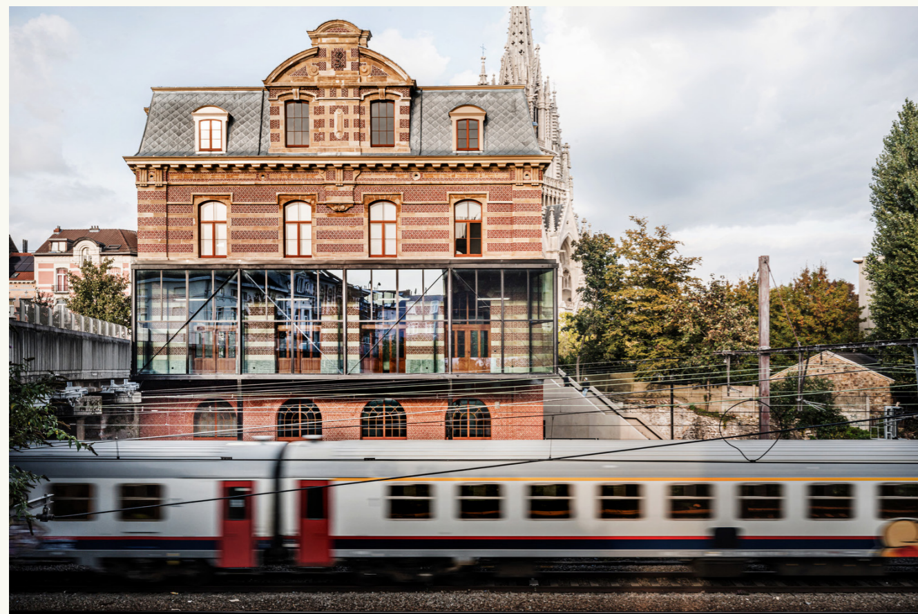
station Laken (B-architecten)
