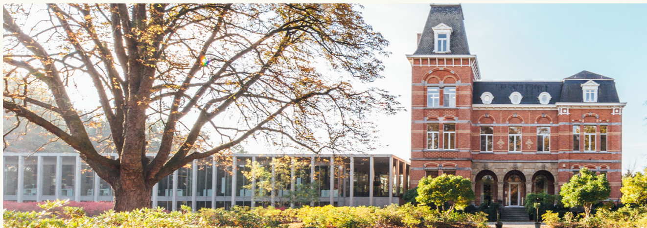
Uitbreiding kantoor: kasteel Ter Poorten Hasselt
